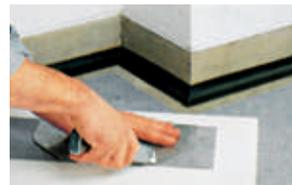
Ángulo de la junta con perfil metálico
