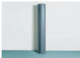
Se cortan los rollos, se marcan y se enrollan holgadamente y se depositan de pie para su aclimatación.
