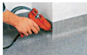
Soldadura con pistola/material de soldadura a juego.
