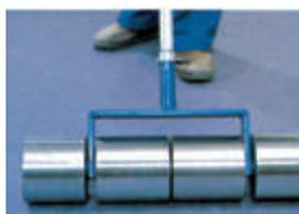
... ó con el rodillo, que gracias a la disposición de sus elementos elimina posibles pequeñas irregularidades ejerciendo presión suficiente sobre el revestimiento.
