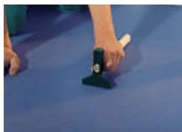
Bolsas en el linóleo ya colocado pueden ser detectadas pasando el mango del martillo sobre la superficie instalada.
