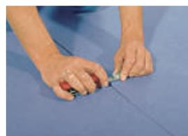
El método mas seguro para el corte de juntas: marcar el rollo superior con el trazador de juntas, el cual es guiado a lo largo del canto del rollo inferior que ya ha sido cortado.
