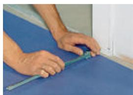
Se marca el perfil de la puerta sobre el linóleo con la ayuda de un escantillón.
