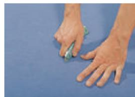
Si no se puede extraer el aire por los lados, se pincha la bolsa en un punto oscuro del marmorizado con el pico del cuchillo, se extrae el aire apretando con el martillo plano y se frota intensamente el revestimiento para que se adhiera bien a la base.
