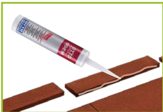
Los bordes **SPORTEC® style** y esquinas deben ser pegados al sub-suelo, así como en las uniones con un adhesivo unilateral. PUR Adhesivo.
