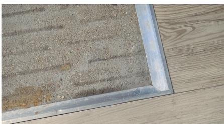
Diseñado para ser recibido con mortero
