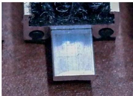
Pour le cas extrême de certains tapis qui sont si grands qu'il est nécessaire de les diviser en deux dimensions ( largeur et hauteur ), comme illustré sur l'exemple du graphique de la droite, il sera nécessaire de fixer au fond de la fosse une paire de platines, avec une séparation entre celles-ci de 20 mm ( voir photo et graphique inférieure ), dans les points sont indiqués en rouge. Dans ces platines ("mâle") doivent être insérés les logements des extrémités des pièces à assembler ("femelle")
